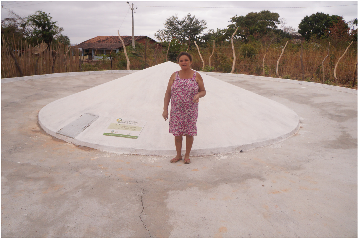
Antonieta apresenta sua Cisterna Chapéu de Padre Cícero. Nela, cabem até 52 mil litros de água armazenada.
